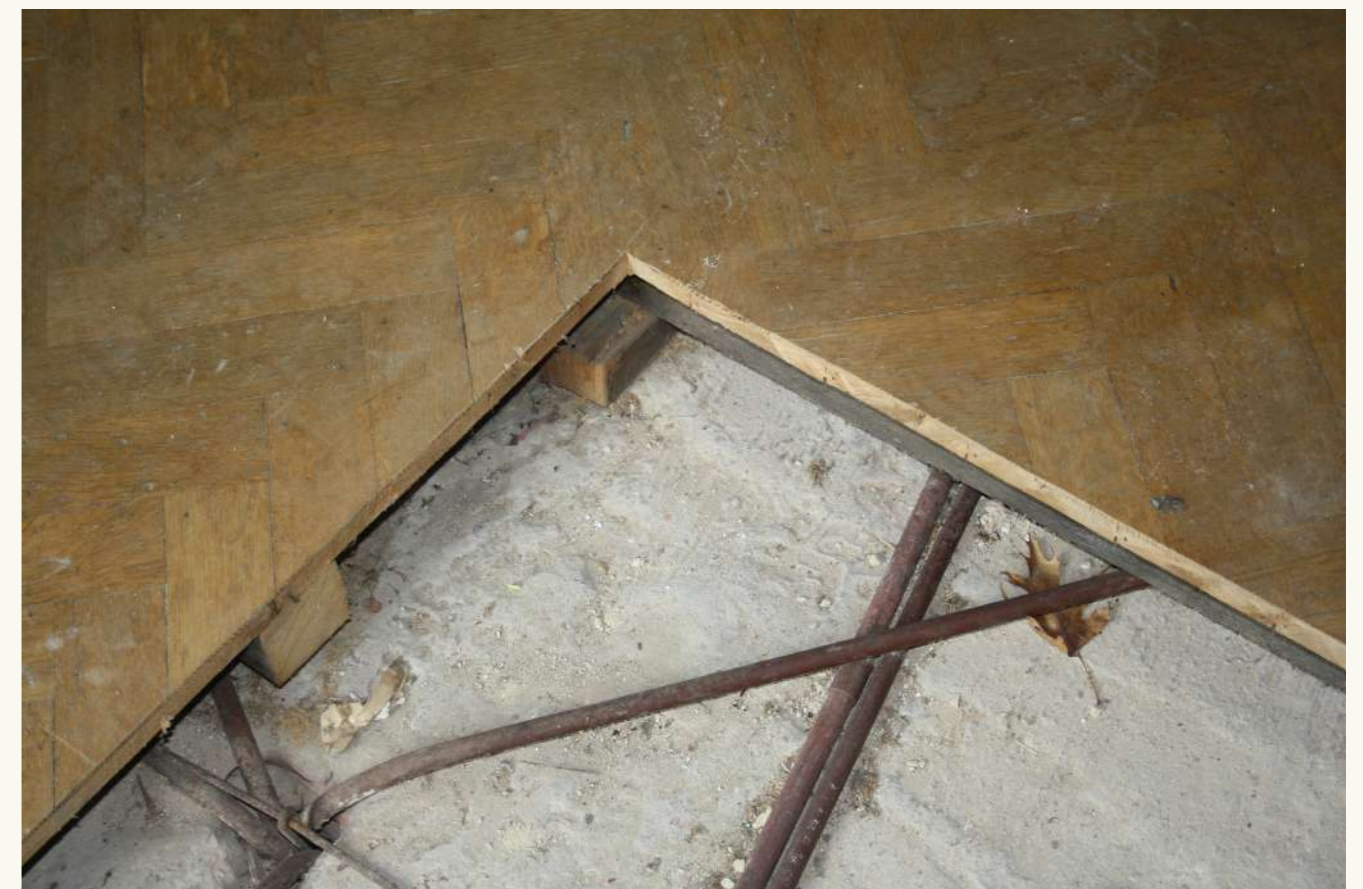
vloeropbouw eerste verdieping leent zich goed tot aanpassingen
