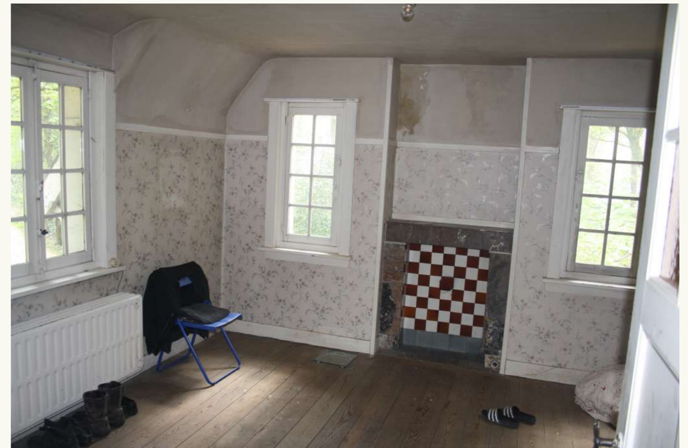
interieur eerste verdieping
