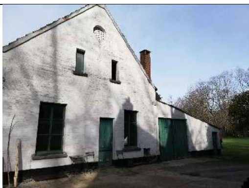
Figuur 20 Bijgebouw Hovenierswoning
