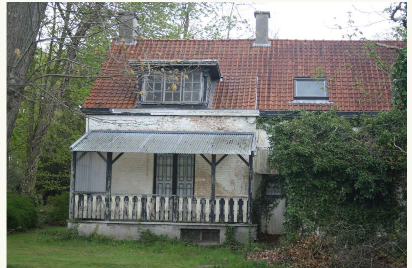
woning paardenmeisje - westgevel
