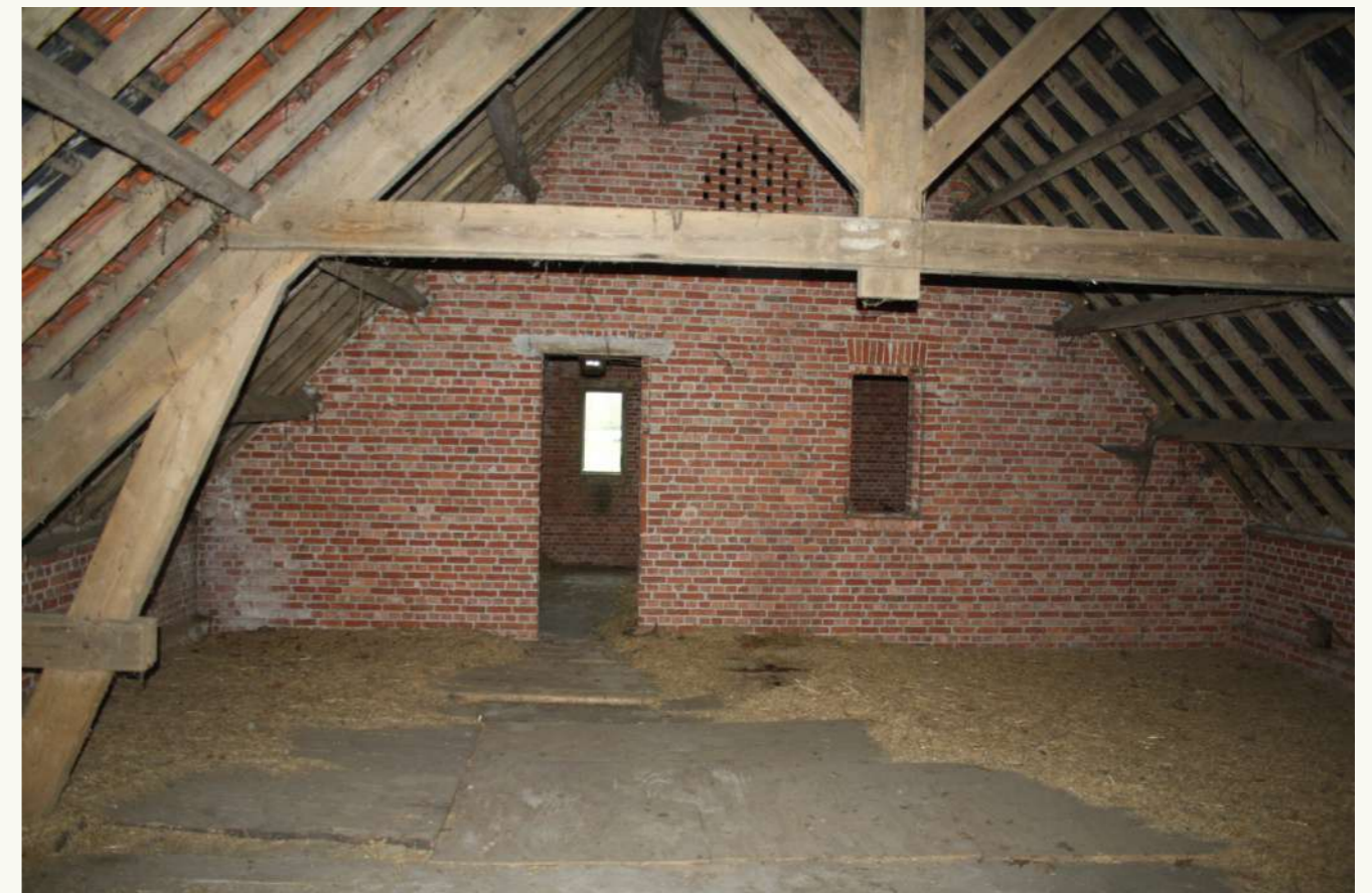
interieur eerste verdieping
