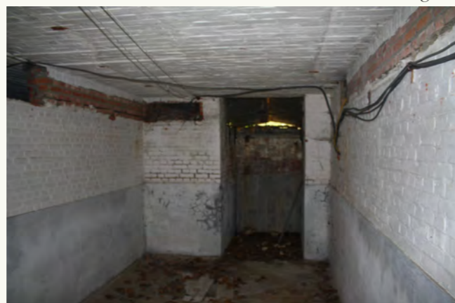
structuur in kelder
