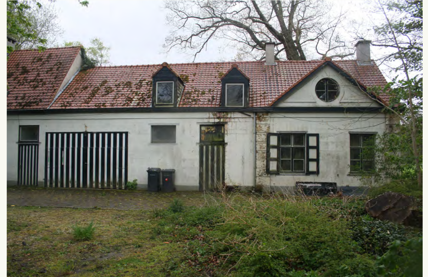
woning paardenmeisje - oostgevel
