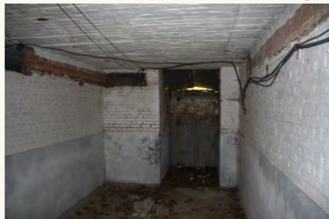
structuur in kelder
